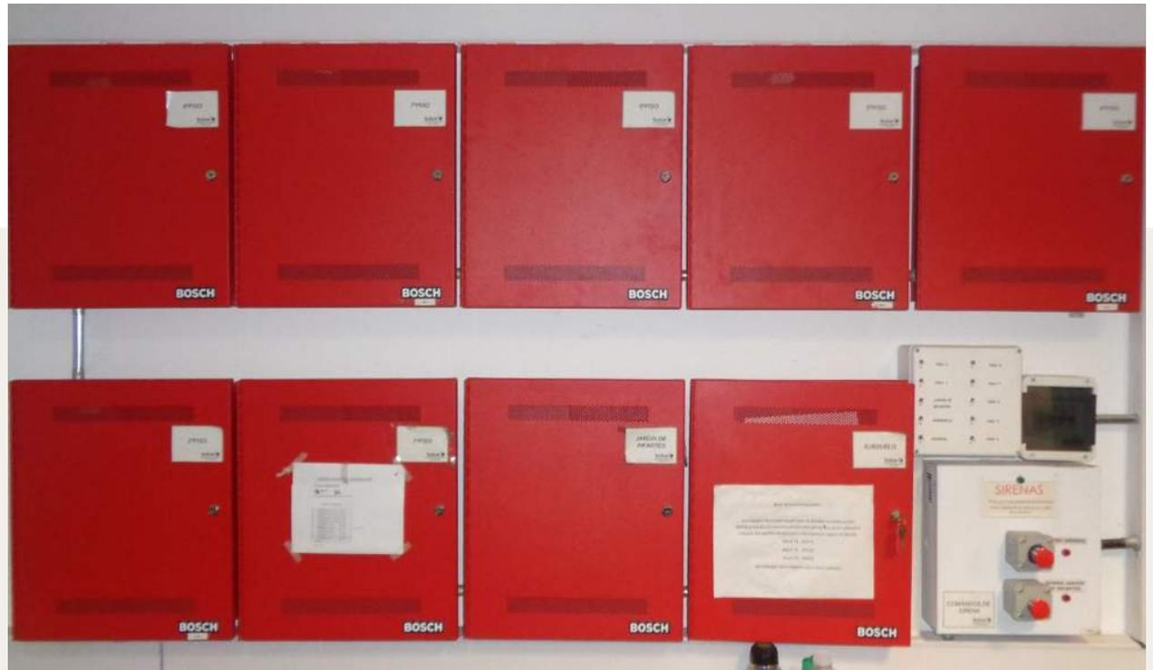
PANELES DE CONTROL DE LOS SISTEMAS DE DETECCIÓN TEMPRANA DE INCENDIO Y AUDIO EVACUACIÓN PERTENECIENTES AL EDIFICIO ANEXO C, LOS CUALES SE ENCUENTRAN EN LA SALA DE SISTEMAS DE SEGURIDAD Y COMUNICACIONES LA CUAL CUENTA CON PERSONAL LAS 24 HORAS.
